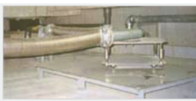
瓦斯配管設置圖
