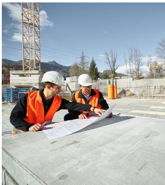
結構隔振抗衝擊工程
