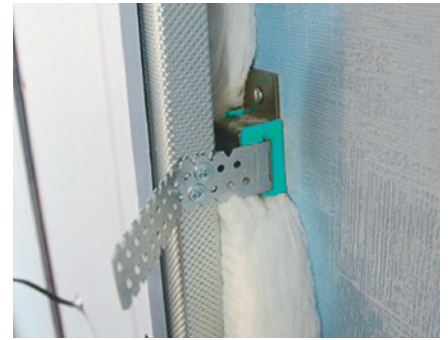
使用 Sylomer® 隔離的角料襯裡 可提供絕佳的阻尼效果
