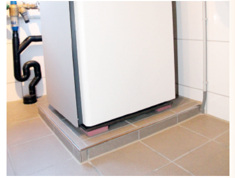
應用於熱力泵的 Sylomer® 點式支撐墊層
