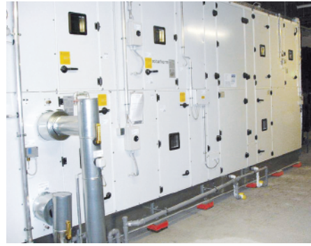
安裝在 Isotop® SE 部件上的空調 (AC) 系統
