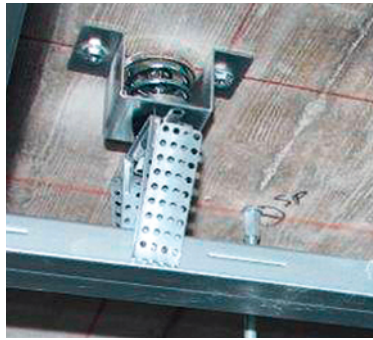
低諧振頻率垂吊式天花板彈簧吊掛件
